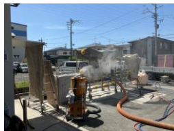
■ワイヤーソー訓練施工
