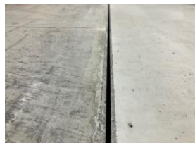
■V溝仕上げ状況
