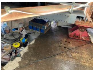
■限られたスペースの中効率よく切断出来るよう配置にする
