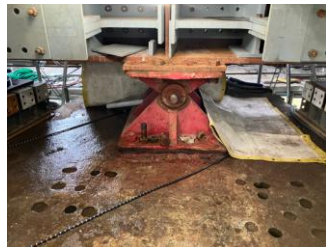
■古い支承の下ヘダイヤモンドワイヤーを巻付け切断する
