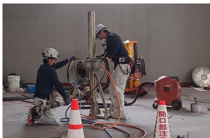
■刃が届かない場所は、乾式ワイヤーソー切断
