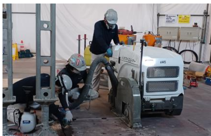
■電気道路カッターによる乾式切断
