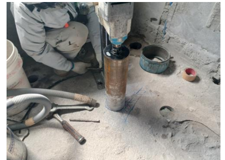
罫書通りにコア穿孔を行う作業員
