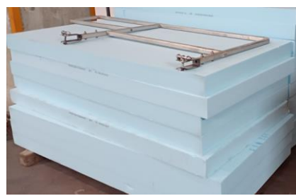
■天井にスタイロを貼って下部の粉塵対策を行う
