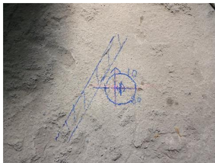
罫書状況：X線画像を元に現地へ罫書を行い誤切断を防ぐ
