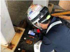
■施工後のイメージ① コア貫通サイズより3サイズ程大きなサイズで表面躯体を削ぎます
