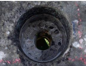
■施工後のイメージ① コア貫通サイズより3サイズ程大きなサイズで表面躯体を削ぎます
