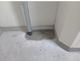
■施工後のイメージ② コアサイズに比べ穴埋め補修範囲が大きくなります
