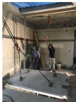
今回のご依頼は切断後の躯体を開口横まで仮置きする迄となっていた。その為、チェーンブロックを駆使しながら撤去する工法を選択した。撤去躯体は1フロアにつき2つ。計4つの躯体を撤去する。
