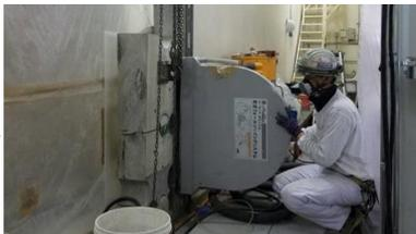
◆工場内に扉をつけるための開口作成。汚泥が出せない現場で、乾式にて粉塵を吸いながら施工。
