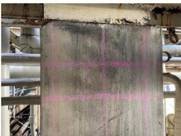
◆アンカー施工のために躯体に罫書き鉄筋位置を出す。
