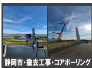
静岡市・撤去工事・コアボーリング
