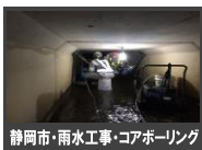
静岡市・雨水工事・コアボーリング
