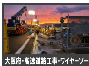
大阪府・高速道路工事・ワイヤーソー
