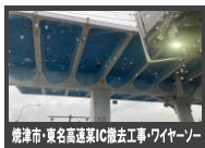
虎津市・東名高速IC撤去工事・ワイヤーソー
