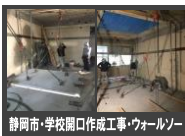
静岡市・学校開口作成工事・ウォールソー
