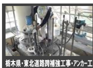
橋本県・東北道路補修工事・アノカ工
