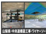
山梨県・中央道橋梁工事・ワイヤーソー
