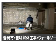
静岡市・建物解体工事・ウォールソー
