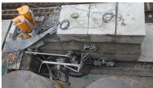
◆狭い場所でも変換プーリーを駆使しワイヤーソーマシンをセット。
