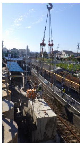
◆橋台も最後の2ブロック。線路が近い事が分かる。
