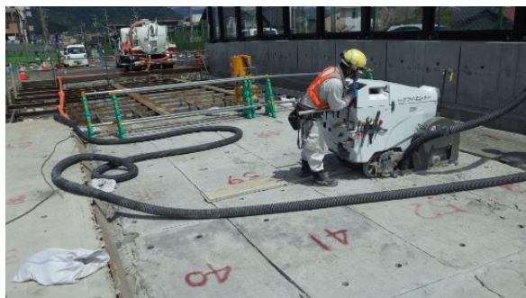
◆作業中の乾式道路カッターとバキュームカー。
