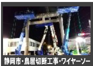
静岡市・鳥居切断工事・ワイヤーソー
