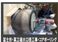
富士市・某工場大口径工事・コアボーリング
