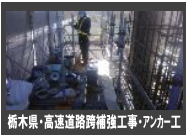
新木県・高速度道路補修工事・アンカー工
