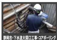
静岡市・下水道大開口工事・コアボーリング
