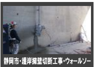
静岡市・護岸擁壁切断工事・ウォールソー
