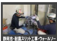
静岡市・耐震スリット工事・ウォールソー
