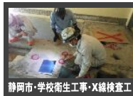
静岡市・学校衛生工事・X線検査工
