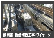
静岡市・橋台切断工事・ワイヤーソー
