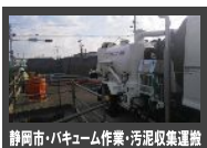
静岡市・バキューム作業・汚泥収集運搬
