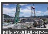
静岡市・パイプ切断工事・ワイヤーソー
