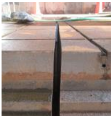
切断ライン(切断後)
