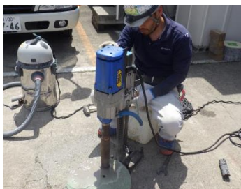
■コンクリート穿孔中。
