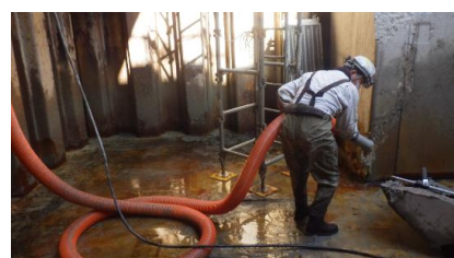
■立坑内に溜まった汚泥を清掃。汚泥の質や面積が広い場合は2名作業とします。
