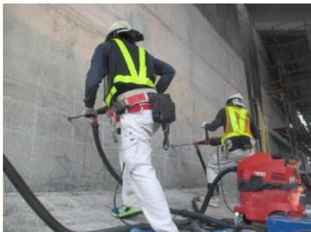
工事内容はアンカー箇所、鉄筋探査・アンカー箇所、樹脂接着、引張試験まで。通常は検査会社とアンカー会社は異なるが、ワイ・エム・ケーではそれらの作業を一貫して行う。まさにワイ・エム・ケーの強みの一つだ。
