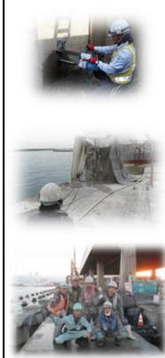
以前は、ハンマードリルで削孔する作業員と清掃を担当する作業員の二名一組での削孔作業を行っていたが、集塵ビットにより清掃担当が不要になった。特に清掃担当者はブラシで孔内を磨き、掃除機で吸う清掃を行っていたため削孔工期の短縮に大きな成果があった。
