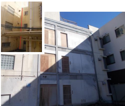
■切断前の状況(赤い線は切断ライン)と切断後の写真
